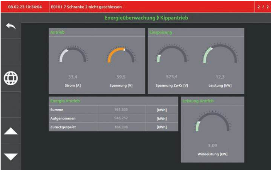
Abbildung 2: Energie Monitoring – Elektroantrieb-Ansicht (Kippantrieb)
