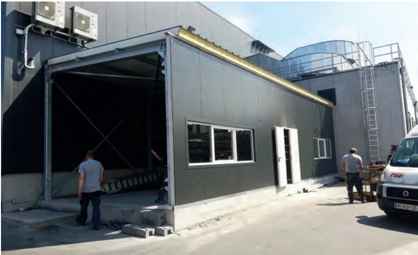
Metall Präzision Halbwachs aus Mank errichtete einen Waschplatz für Aluminiumussteile der Firma CSA in Herzogenburg unter Berücksichtigung besonderer Sicherheitsvorkehrungen.
