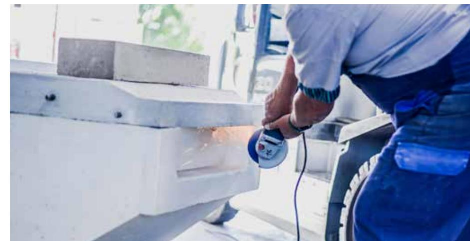
Abb. 3: Ausbruch der alten Auskleidung und Einsatz des neuen Feuerfestwechselteils können direkt vor Ort beim Kunden erfolgen. So entfallen lange Transportwege. Bild: StrikoWestofen.
