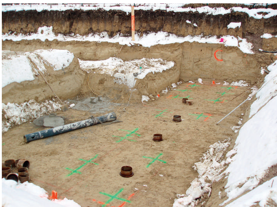
Abb. 6: Die Pfahlgründung für die Fundamente des Betriebsgebäudes der Wiener Bestattung GmbH musste in nur 4 Wochen abgeschlossen werden.
