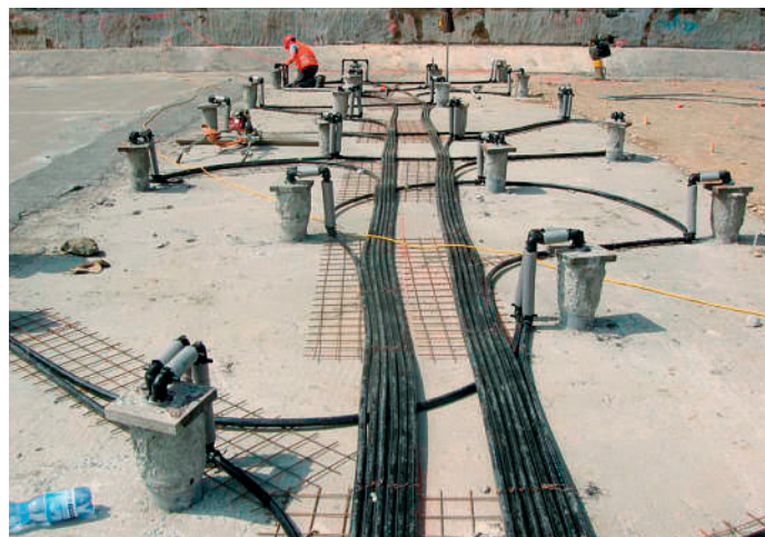
Abb. 8: Verlegung der Absorberleitungen in die Rammpfähle und die Bodenplatte am Standort Salzburger Hauptbahnhof.
