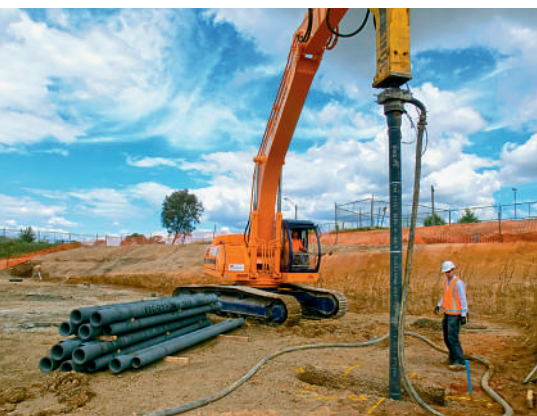
Abb. 4: Gründungsarbeiten für die Wohnresidenz „Quest“ in Wodonga (Victoria), Australien
