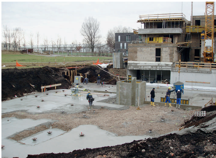
Abb. 5: Laut Bodengutachten musste die gesamte Fläche des Wohnkomplexes durch Pfahlgründungen gesichert werden. Dazu waren 16.000 duktile Pfähle notwendig.
