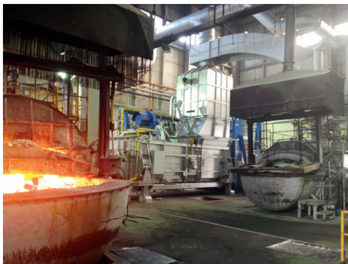
Modernisierung mit Weitblick bei der Gießerei „Inzi Amt“: Der verbaute StrikoMelter senkt den Energieverbrauch von mehr als 120 Kubikmeter Erdgas pro Tonne geschmolzenem Aluminium auf unter 60 Kubikmeter. (Bild: StrikoWestofen)
