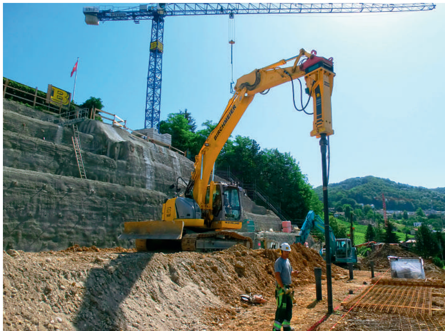
Abb. 1: Pfahlgründung für die Wohnresidenz „Akaziensteig“ in Klingnau, Kanton Argau, Schweiz.
