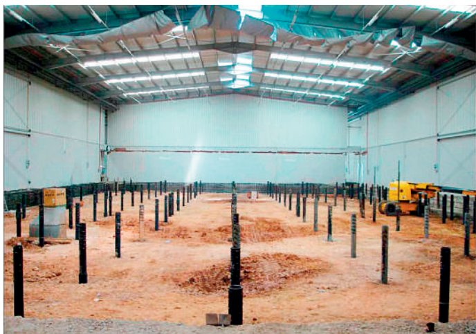
Abb. 7: Nachgründung einer Industriehalle in Bobadela (Loures), Portugal
