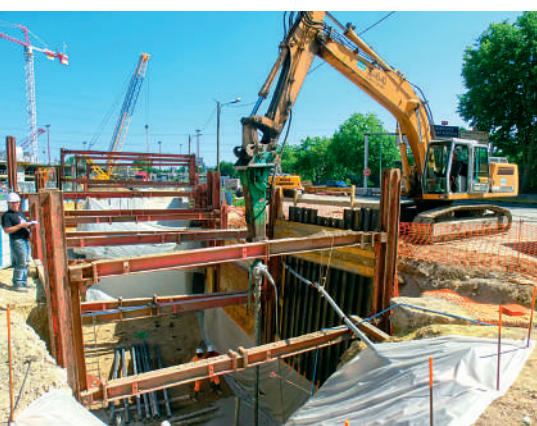
Abb. 3: Pfähle im Einsatz bei einer Straßenunterführung an der Seine in Ville-neuve-la-Garenne, Frankreich
