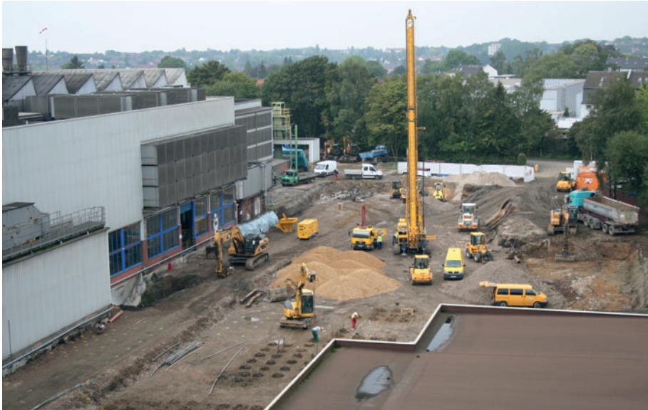
Hallen-Neubau auf dem Gelände von Georg Fischer Mettmann
