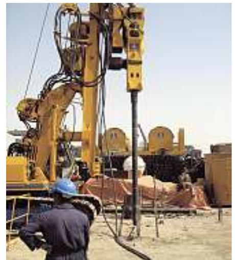
zeigte hervorragende Ergebnisse. Bei Erreichen der Gebrauchslast von 1.000 kN trat eine Setzung von 9,46 mm auf, was nach Entlastung einer bleibenden Setzung von
