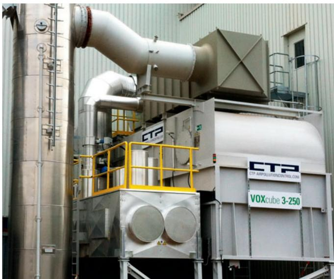
Abb. 2: RTO Anwendung in einer Aluminium-Gießerei in Deutschland
