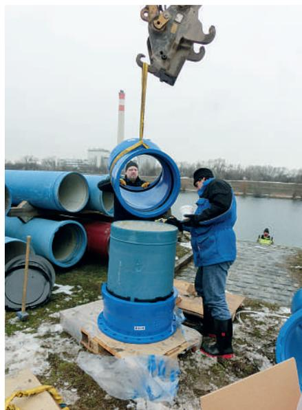
82 Meter Rohre und acht Formstücke DN 600 waren nötig, um die Druckleitung für die Wildwasserstrecke auf der Donauinsel zu verlegen.
