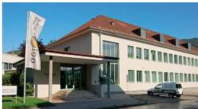
Mit einem Kostenaufwand von rd. € 120.000,- wurde das Bürogebäude, Baujahr 1954, mit neuen Fenstern und einem Vollwärmeschutz thermisch saniert.
