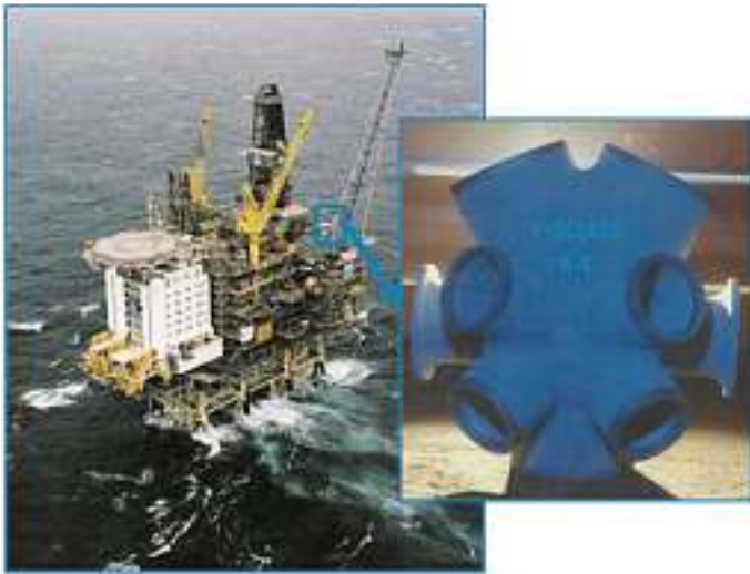
Abbildung 2: Offshore-Plattform „BRAGE“ mit Knoten aus Stahlguss, die in das tragende Fachwerk eingeschweißt sind
