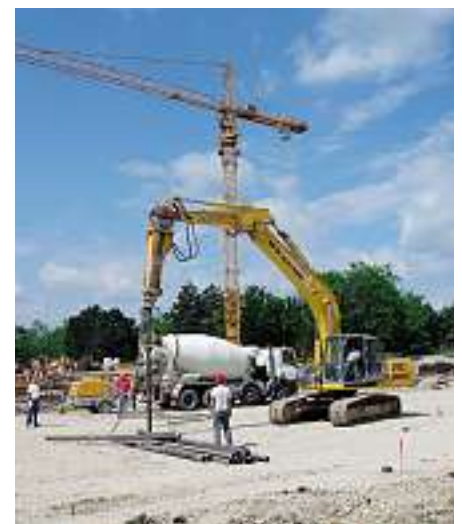
Baustelle Therme Oberlaa
