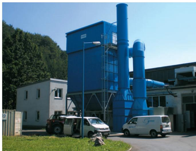
Bild 2 : SLR-Gusskühler-Entstaubung
