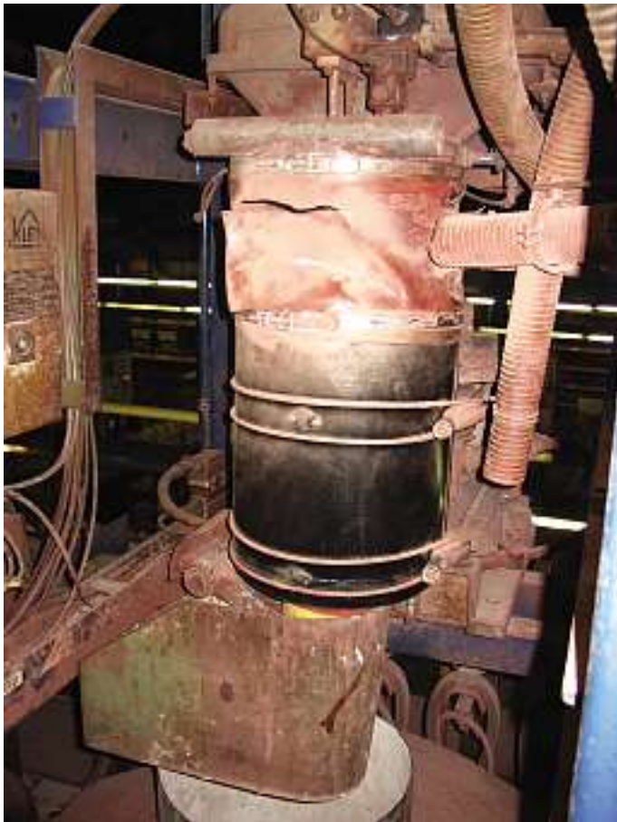
Bild 2: Rotes Eisenoxid verursacht eine erhebliche Verschmutzung der Kernsandaufbereitungsanlage
