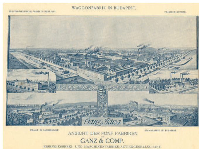
Abb. 20 Ansicht Gießerei Ganz Budapest
