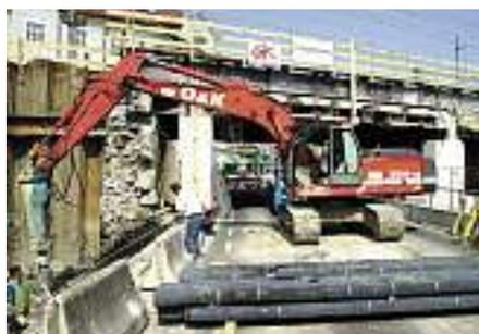
Plainstraße und über die Rainerstraße erneuert. Die 100 Jahre alten Stahlbrücken werden abgetragen und durch helle Neubauten ersetzt. Die Durchfahrts Höhe von derzeit 3,60 Meter wird auf 4,20 bzw. 4,60 Meter angehoben.
