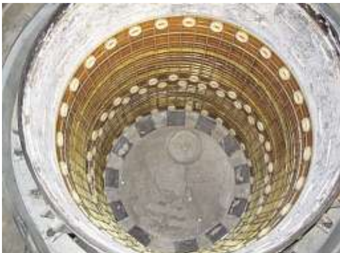
Bild 7: Einbau des OCP-Sensorkabels
